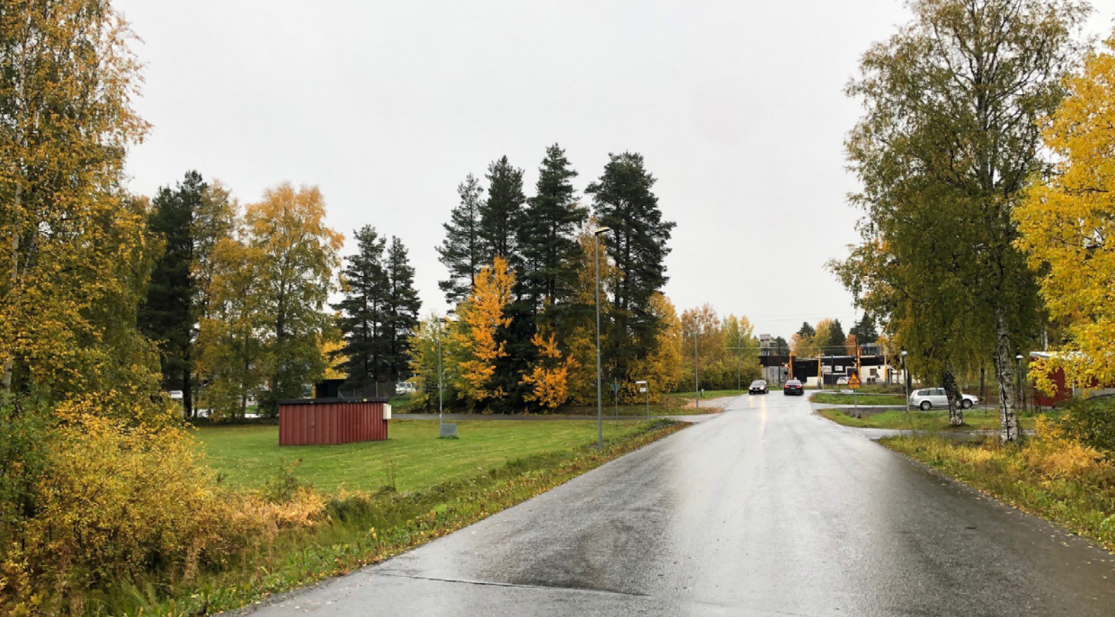
Figur 6. Snickerivägen väster om järnvägen i östlig riktning. En av huvudinfarterna till Krokoms centrum, Foto WSP 2020.
