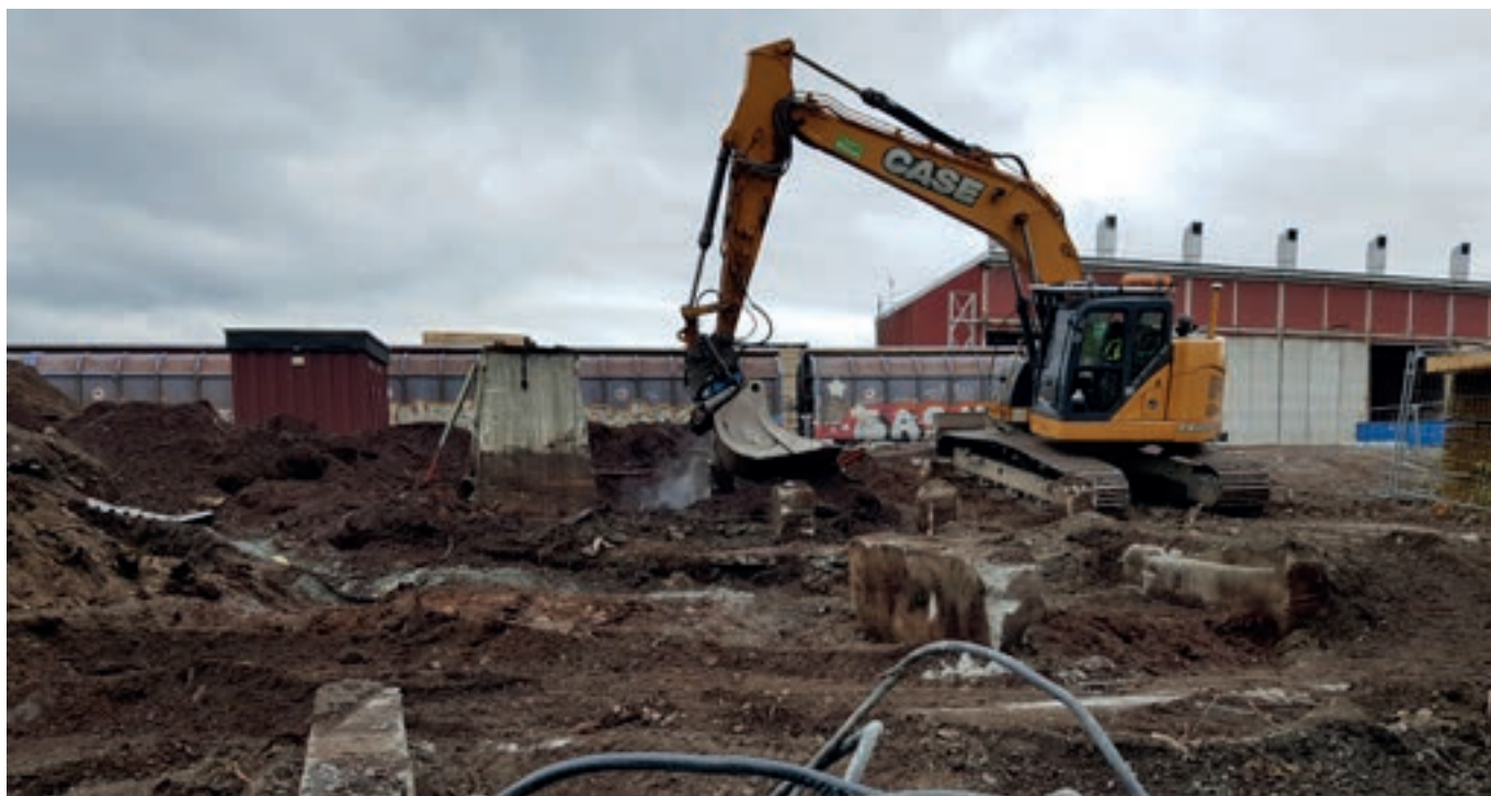
Saneringsarbete i Hissmoforsområdet.
