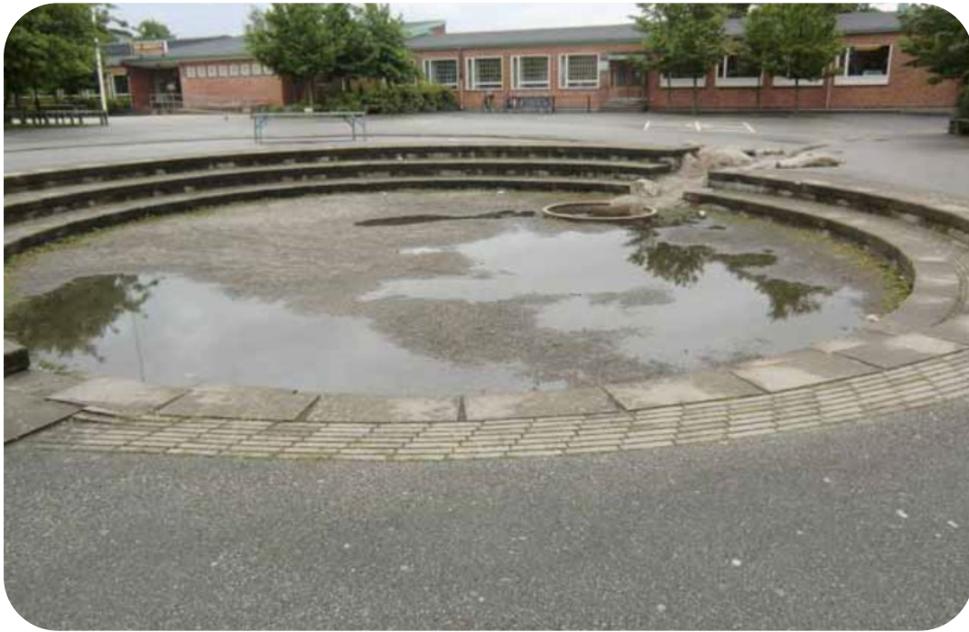
Bild 5. Amfiteater på skolgård. Vid höga flöden kan ytan översvämmas. Grusbotten möjliggör infiltration.
