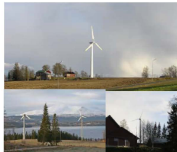
Exempel på ”gårdsverk”: Överst 100 kW verk i Överhallen. Th 15 kW verk i Bynom. Nere tv 100 kW och 22 kW i Bratteggen.
