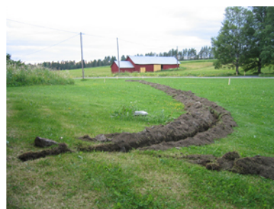
Uppräst spår för förläggning av fiber i Trångsviken.
